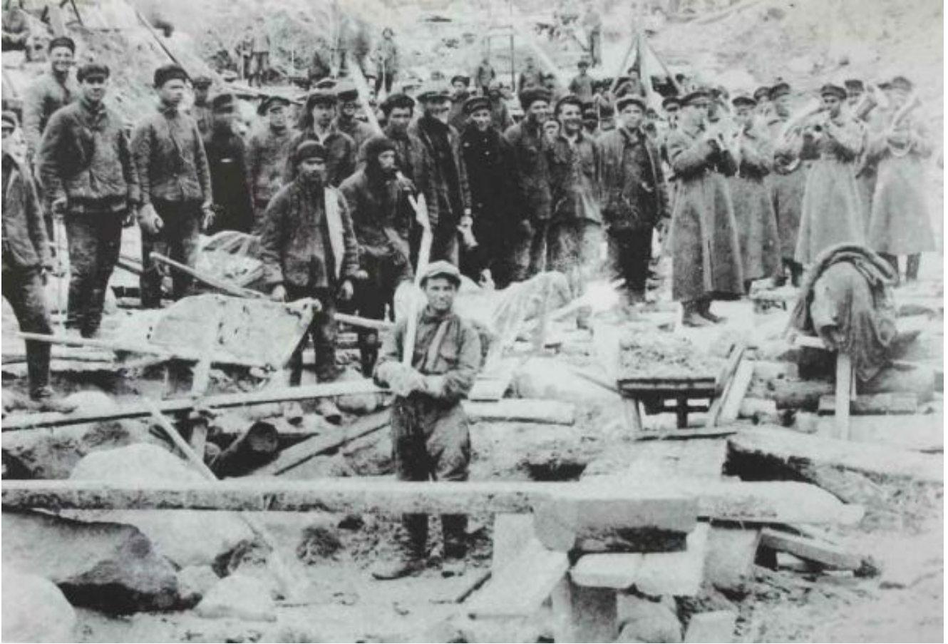
La orquesta del Bielomorkanal. Se suponía que la construcción del canal, empresa absurda, estaba justificada por la reeducación de los detenidos
